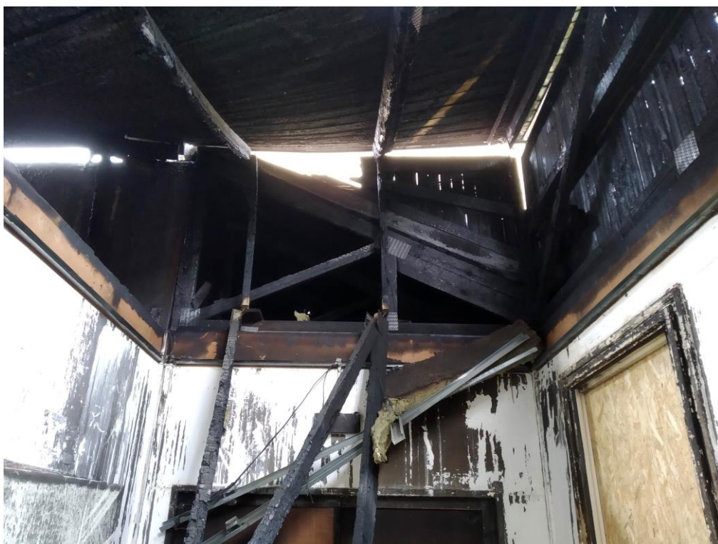
KRAJNÍ VAZNÍK (SPOJOVACÍ CHODBA „A“)
